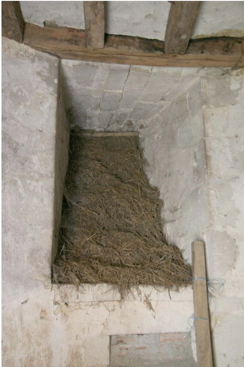
Tourelle, rez-de-chaussée, fenêtre haute.
