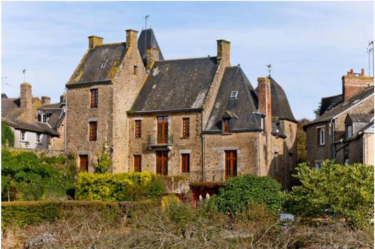
26 Grande-rue, façade sur jardin.
