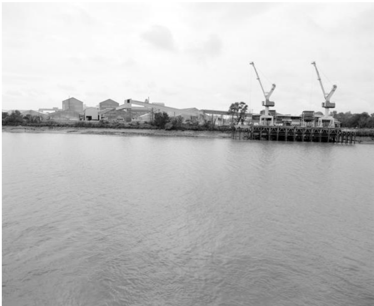
Vue générale du site depuis Bouguenais (1997).
