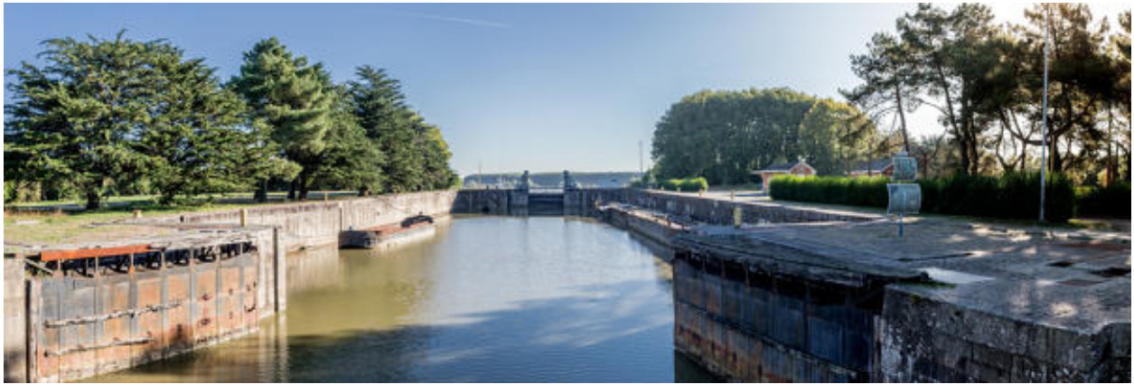
Vue du sas de l'écluse vers l'amont.
