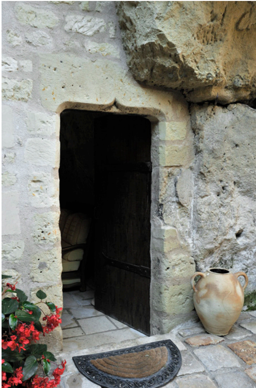
Premier fontis, détail de la porte d'un habitat troglodytique ancien, avec linteau chanfreiné à accolade (récemment rehaussé de deux assises).
