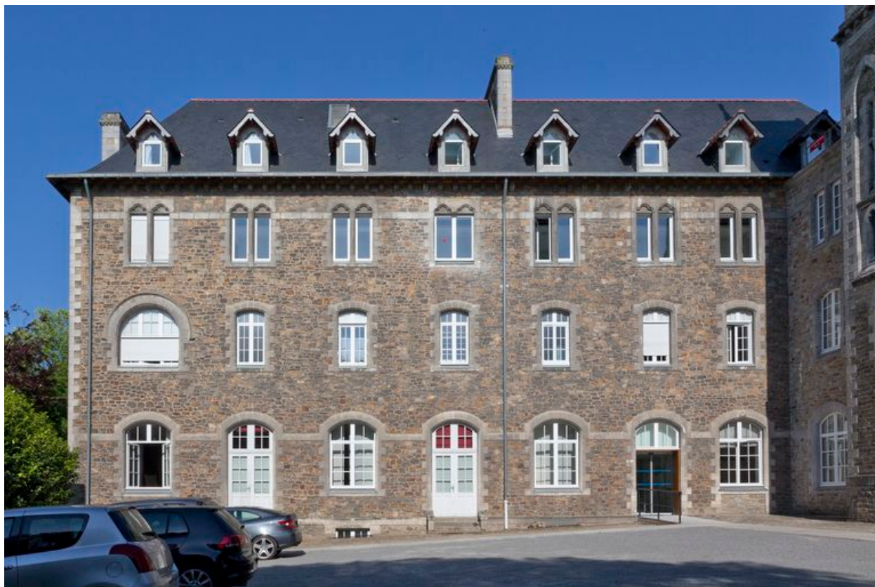
3 : bâtiment de la communauté, façade est.
