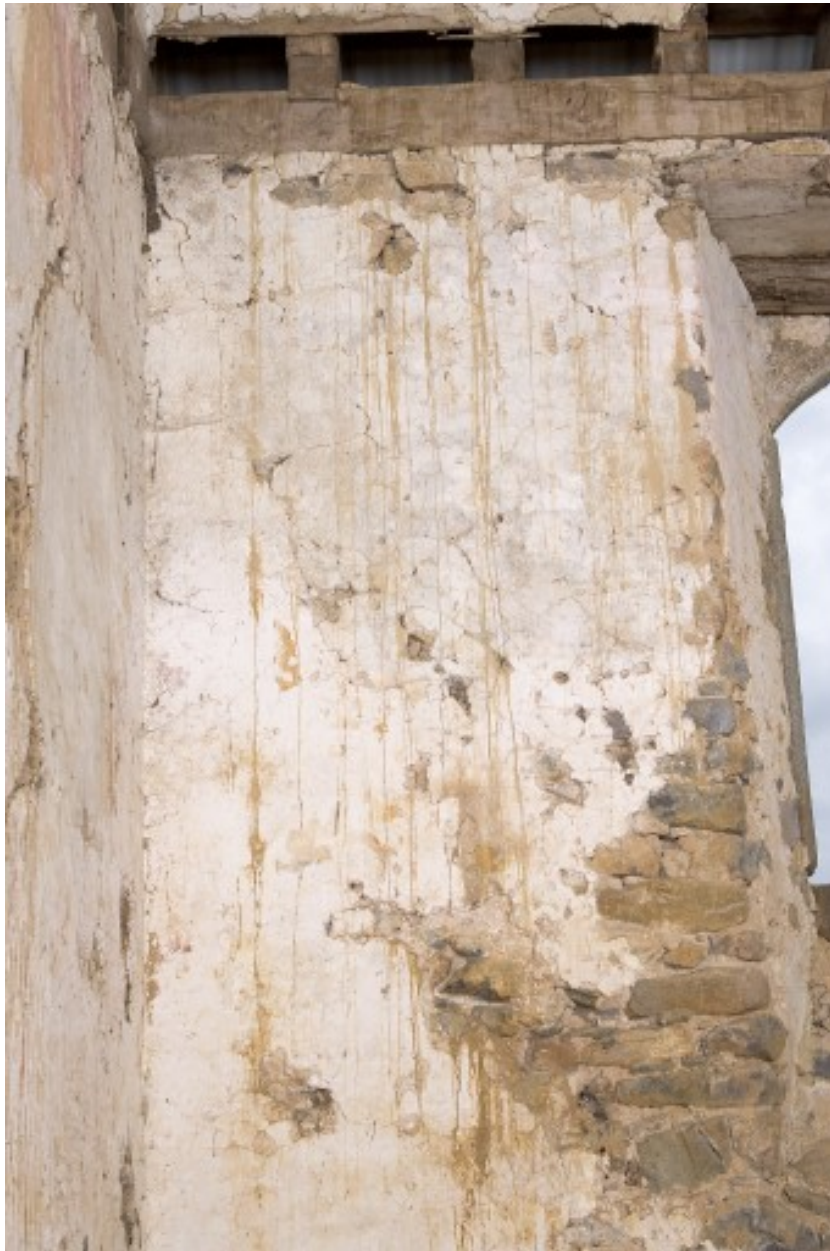
Mur sud, partie gauche.
