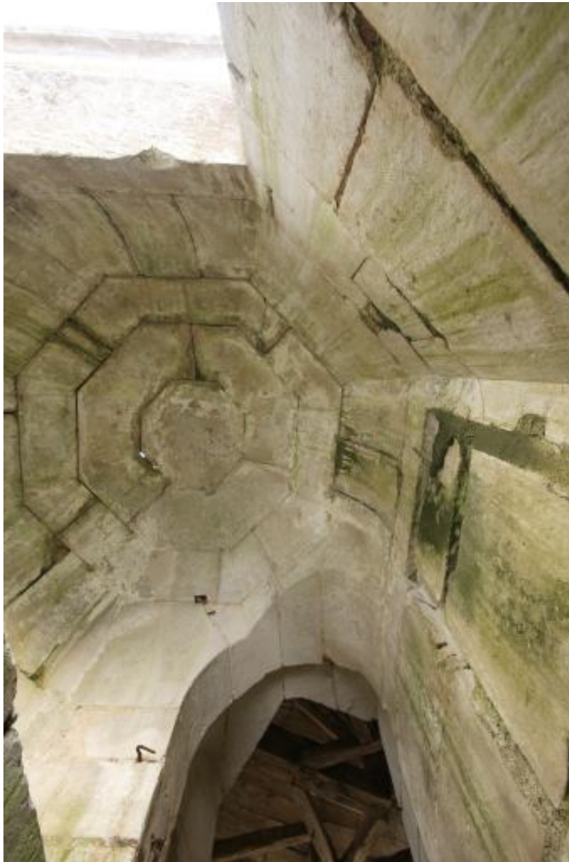
Partie supérieure de l'escalier, couvert d'une coupole octogonale.
