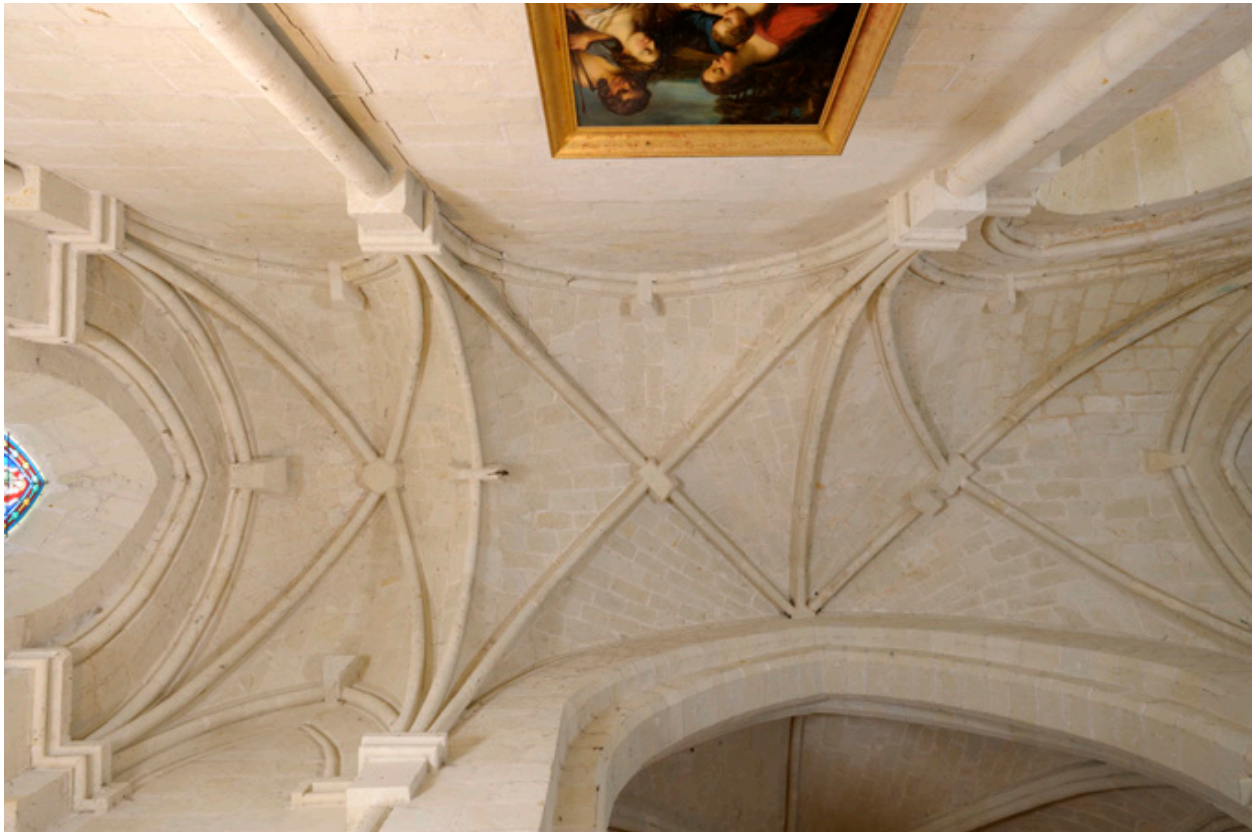
Voûtes de la chapelle et du bras nord du transept.
