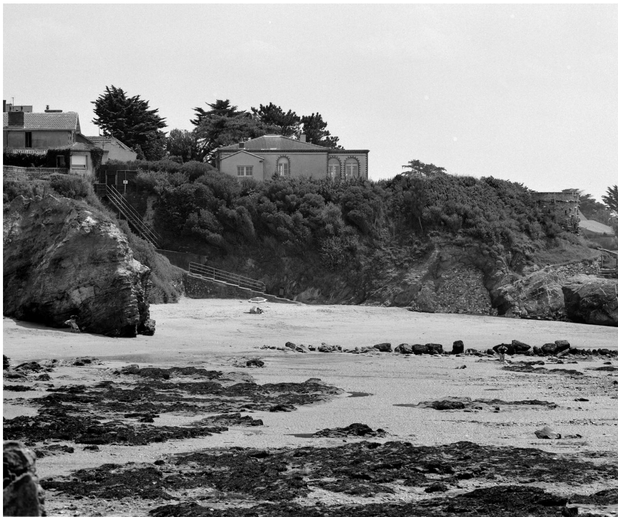
Elévation ouest vue de la plage en contrebas.
