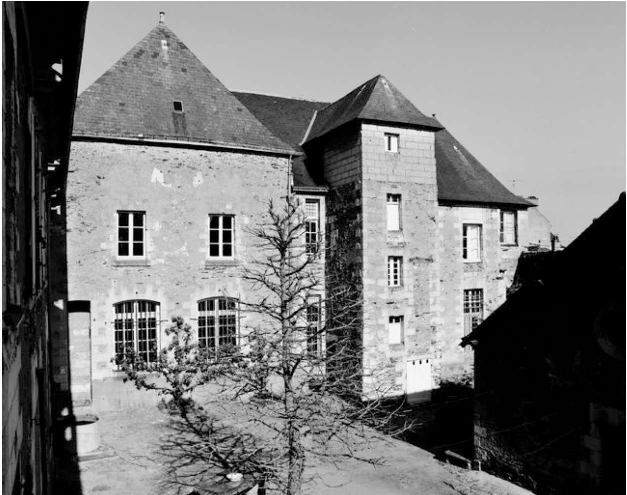
Bâtiments sur la cour de service : façades ouest de l'avant-choeur ou vestibule des religieuses (à gauche) et de la grande sacristie/salle du chapitre (à droite).
