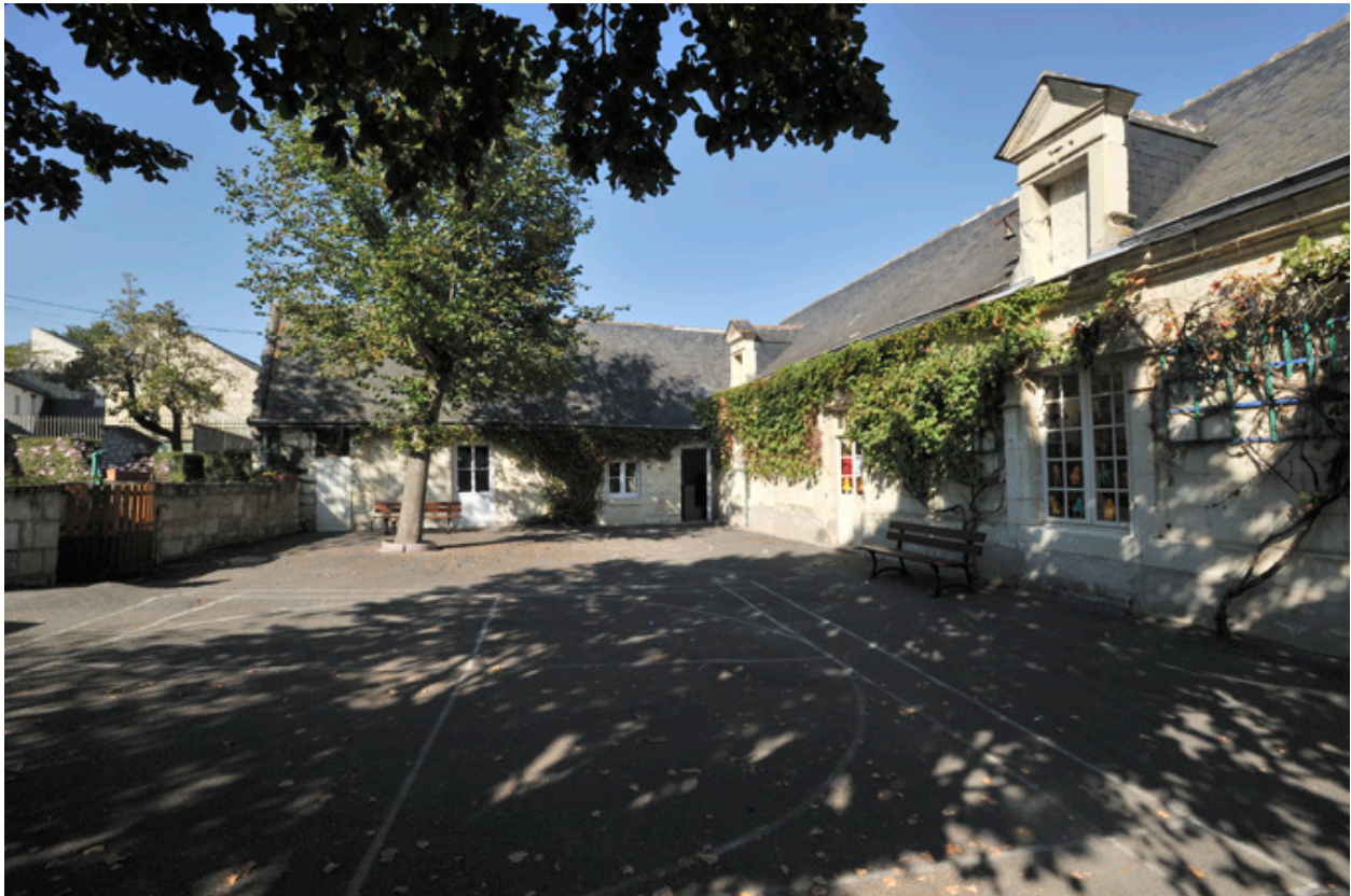
Corps principal et aile ouest, depuis la cour.
