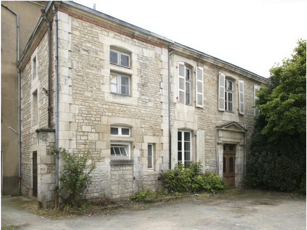
Ancien hôtel Surineau de la Ménolière (fin XVIIIe), inclus dans l'école Notre-Dame : façade ouest.
