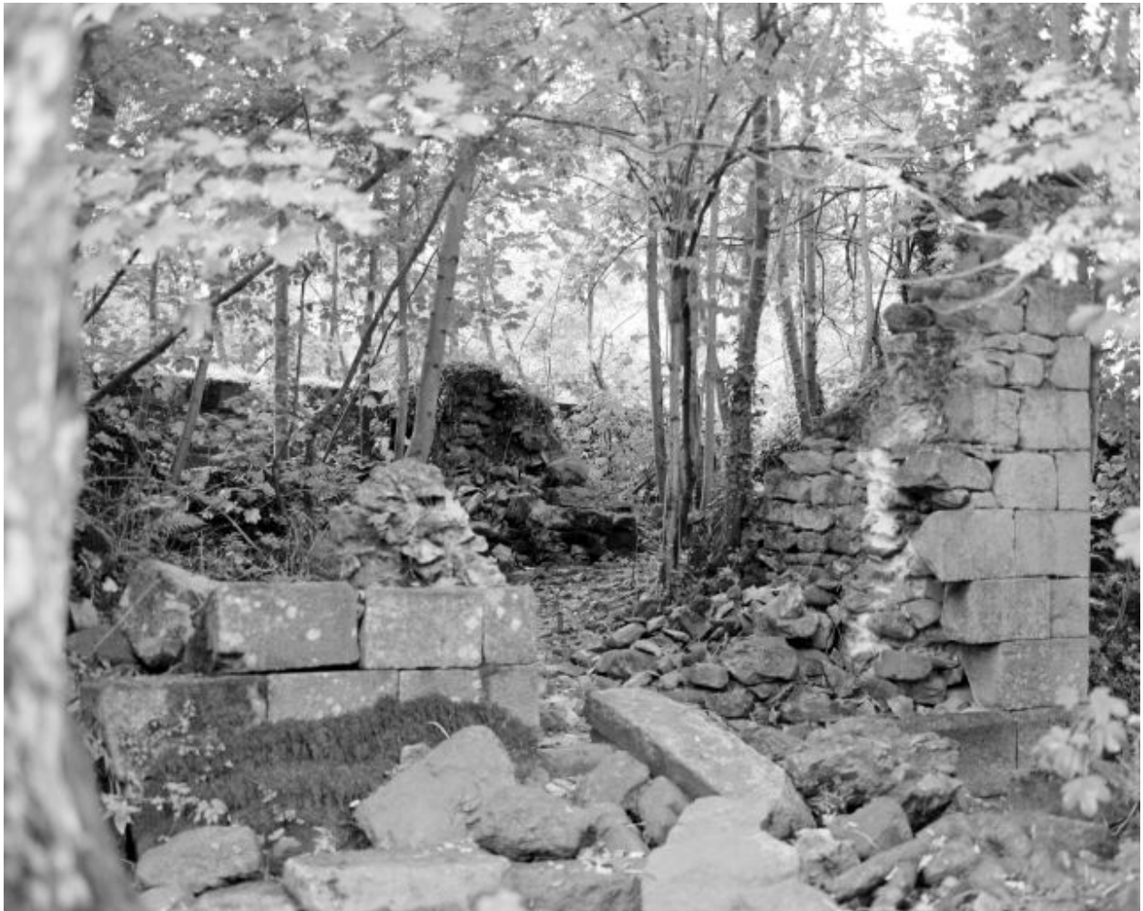
Les vestiges de la façade ouest du moulin des Communes.
