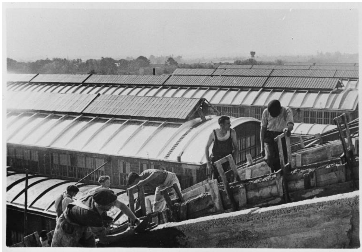
Atelier G en reconstruction, réalisation des arcs par coffrage.
