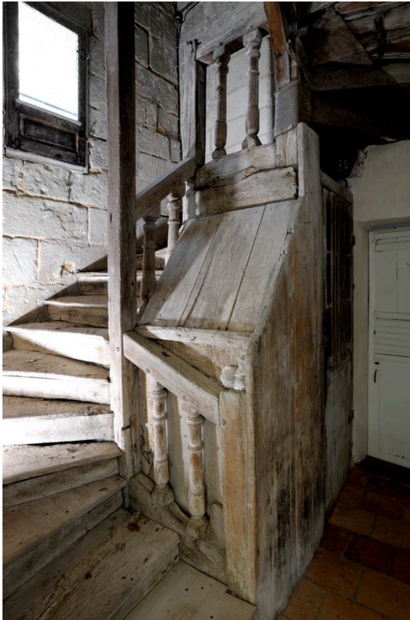
Escalier tournant suspendu, en charpente et à balustres tournés (2e moitié XVIIe siècle).
