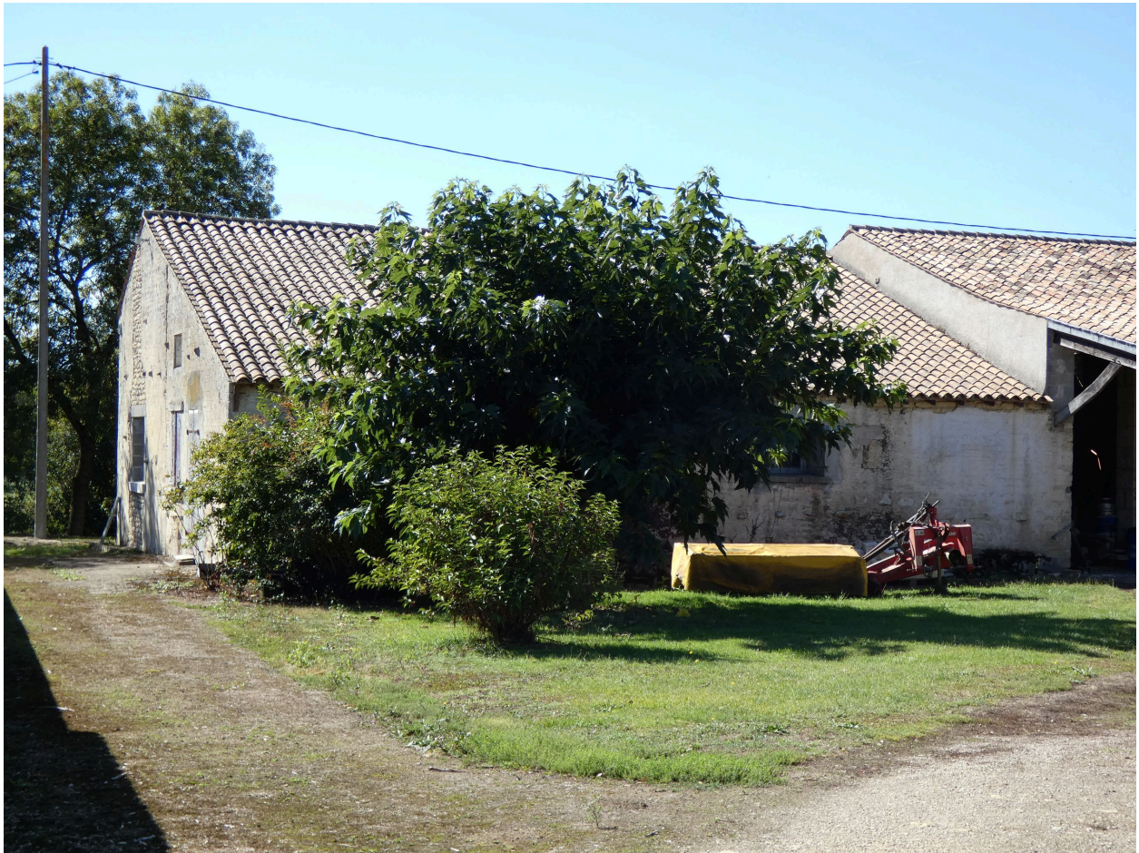
Les dépendances en appentis à l'arrière du logis, vues depuis l'est.
