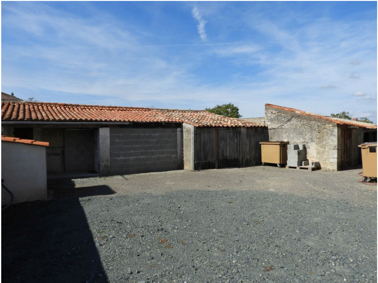
Remises à l'ouest de la cour ouest.
