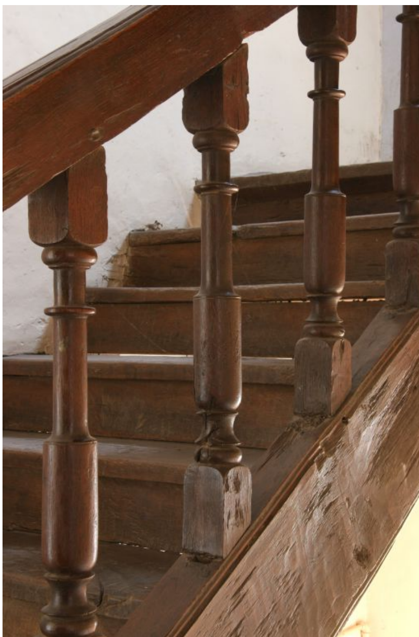
Escalier dans œuvre : les balustres.
