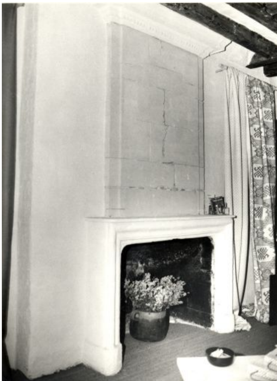
1er étage, pièce antérieure, mur gauche.
