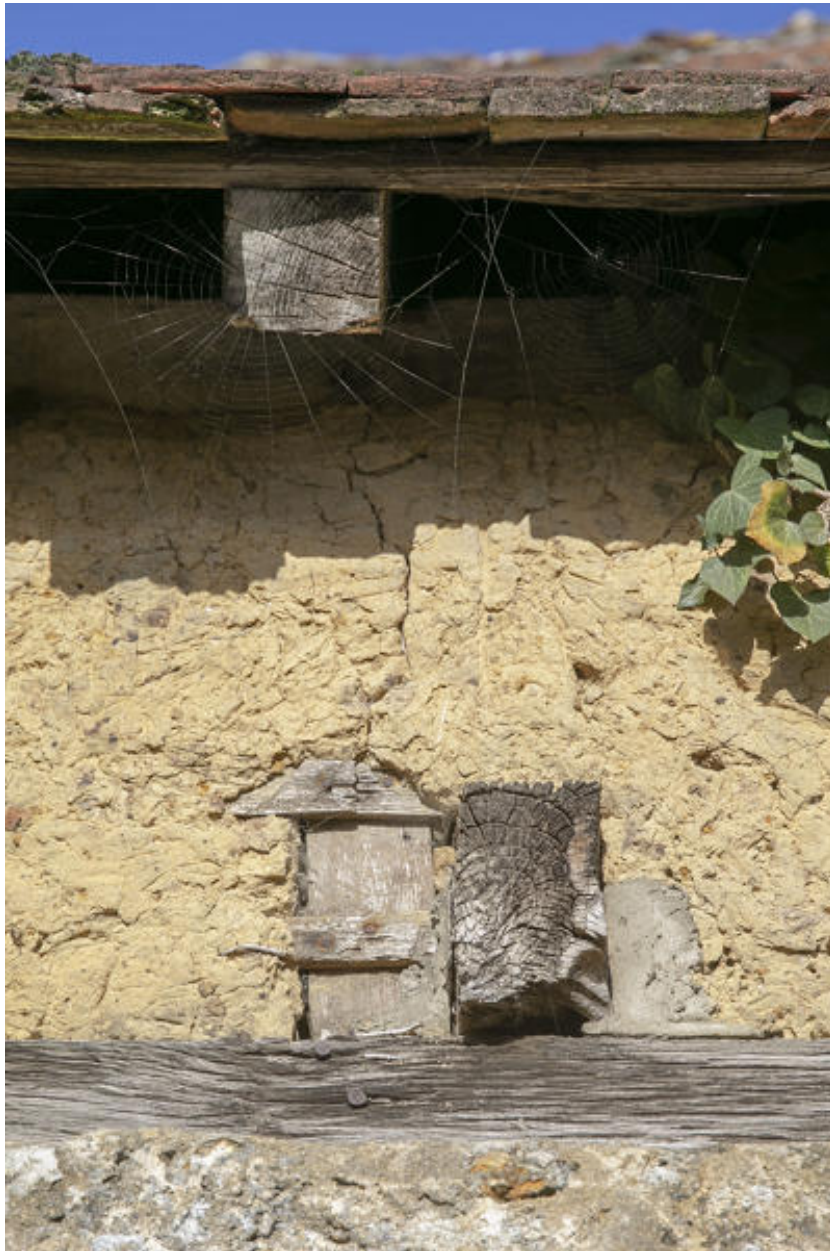
Un détail de mise en oeuvre bois et torchis, impasse de la Forge.
