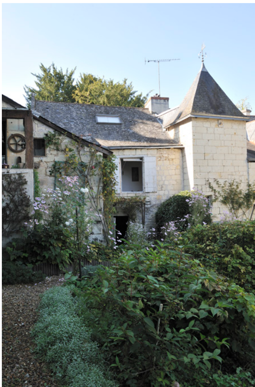
Aile ouest, avec tourelle d'escalier.
