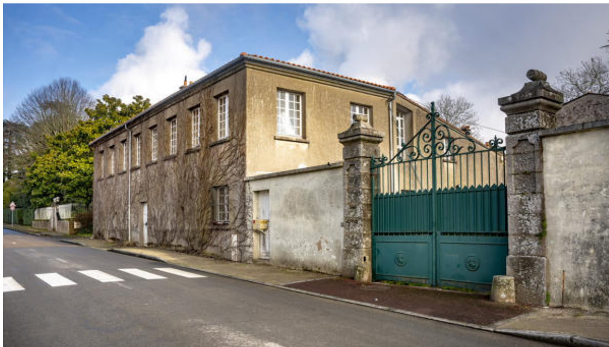
Portail d'entrée et bureaux.
