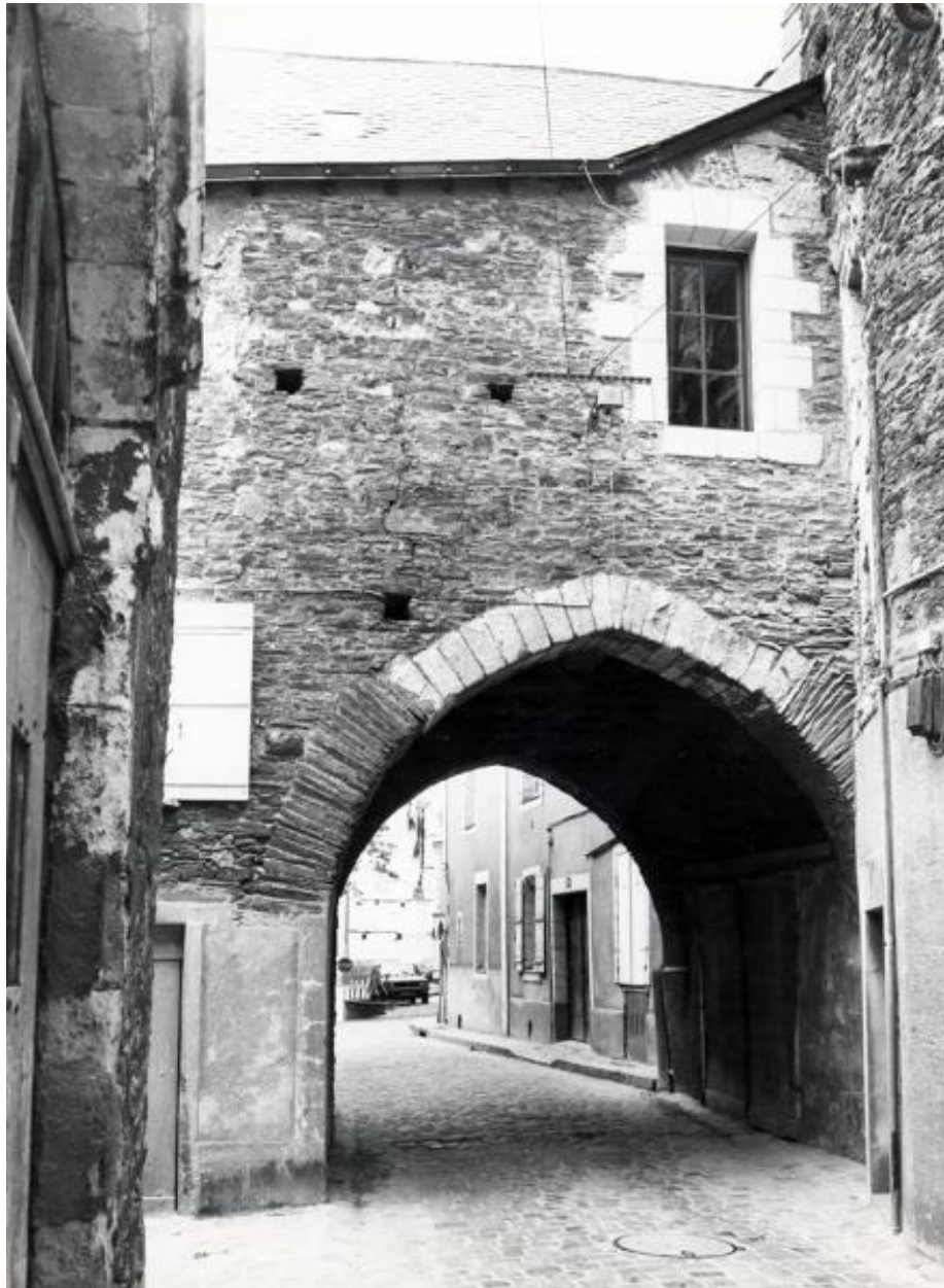
Passage couvert, rue de la Censerie : élévation extérieure nord.
