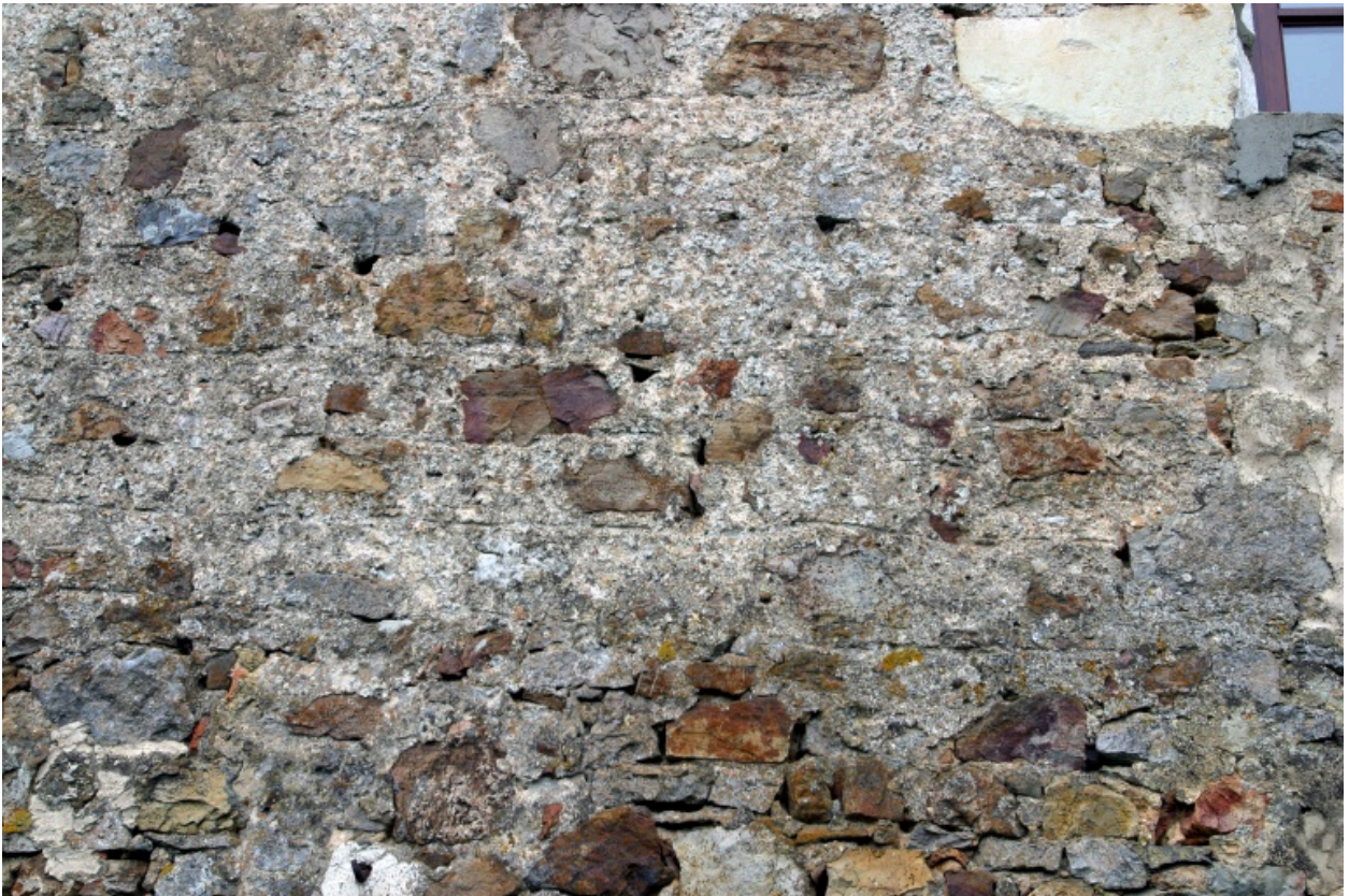
Détail de la façade postérieure : enduit décoré de faux-appareil.
