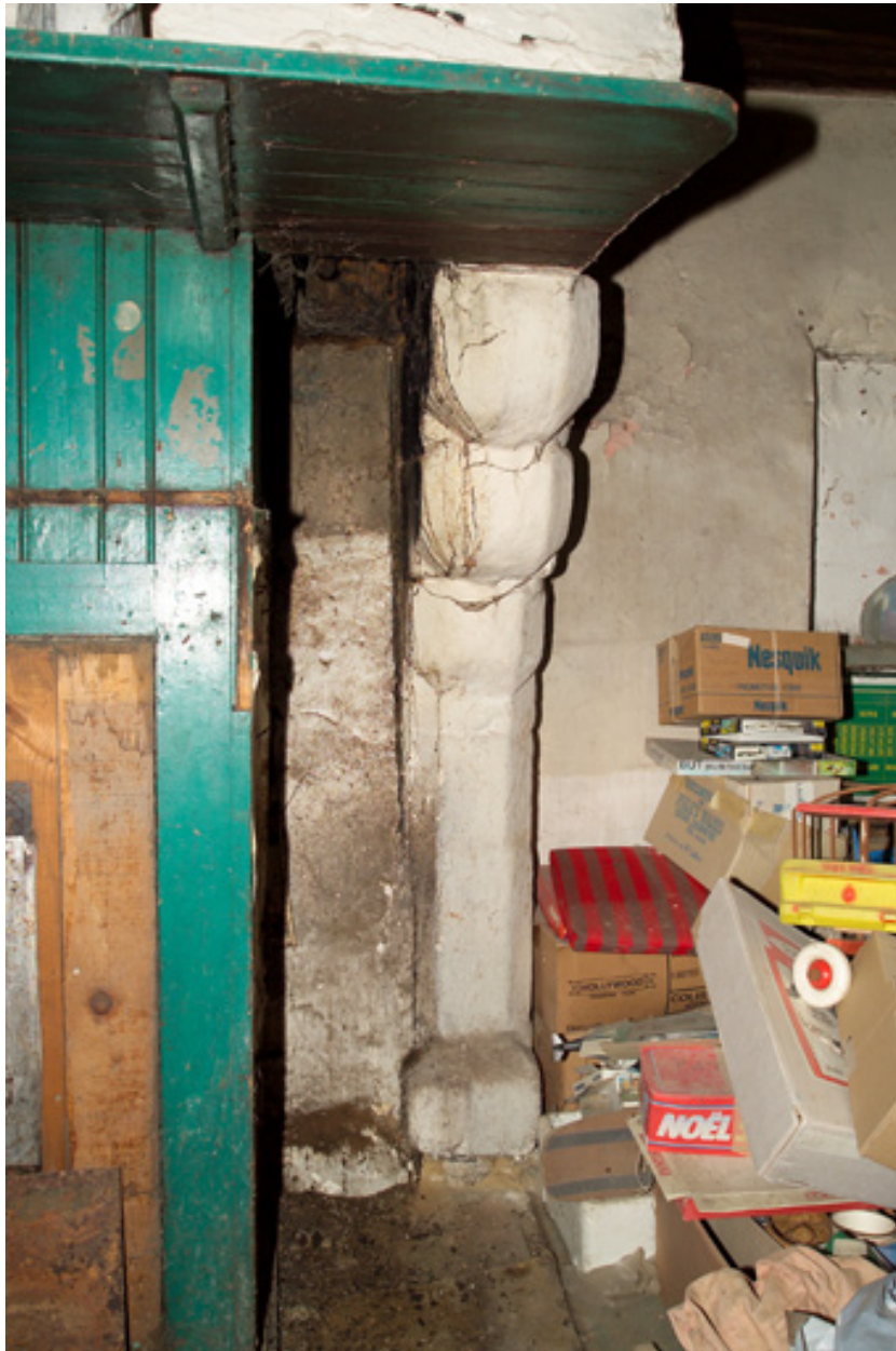
Corps principal, premier étage, pièce orientale, cheminée, détail du montant droit.
