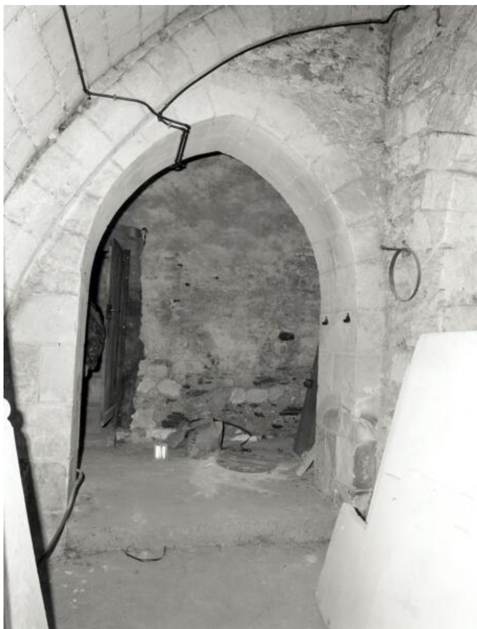
Aile ouest du cloître, rez-de-chaussée à usage de communs, mur sud au contact de la descente de cave, porte est : vue d'ensemble.
