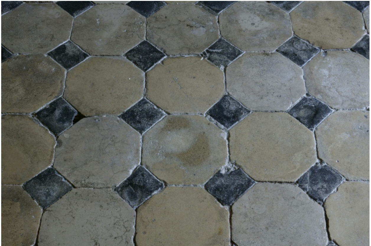
Carrelage en pierre dans le couloir au rez-de-chaussée.
