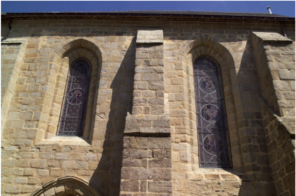
Mur sud, détail des baies des troisième et quatrième travées.
