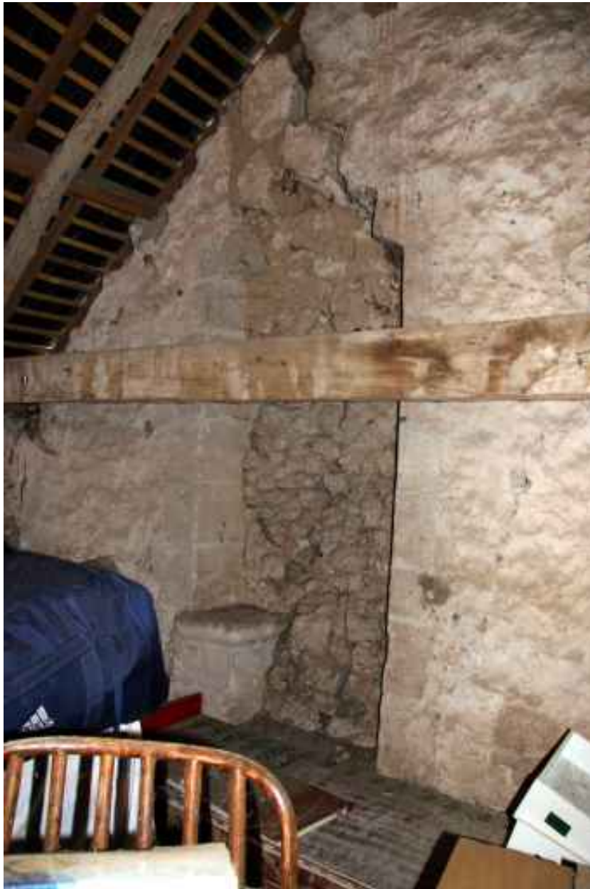
Logis annexe, 1er étage : vestige d'une 2e demie baie à coussiège sur le pignon O.
