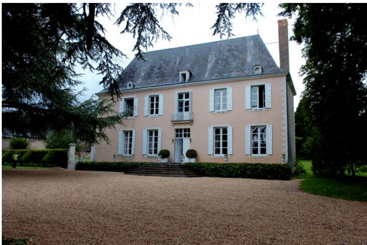
Le logis vu depuis le pavillon de la chapelle.
