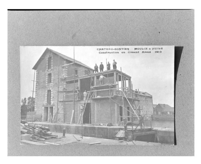
Le moulin vu du sud-ouest lors de la construction de l'extension en béton et en brique, en 1913.
