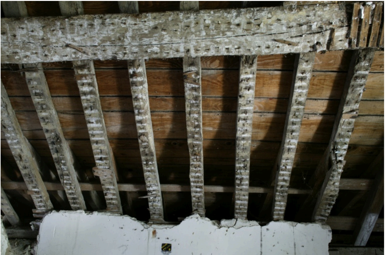
Charpente, détail des traces du lattis.
