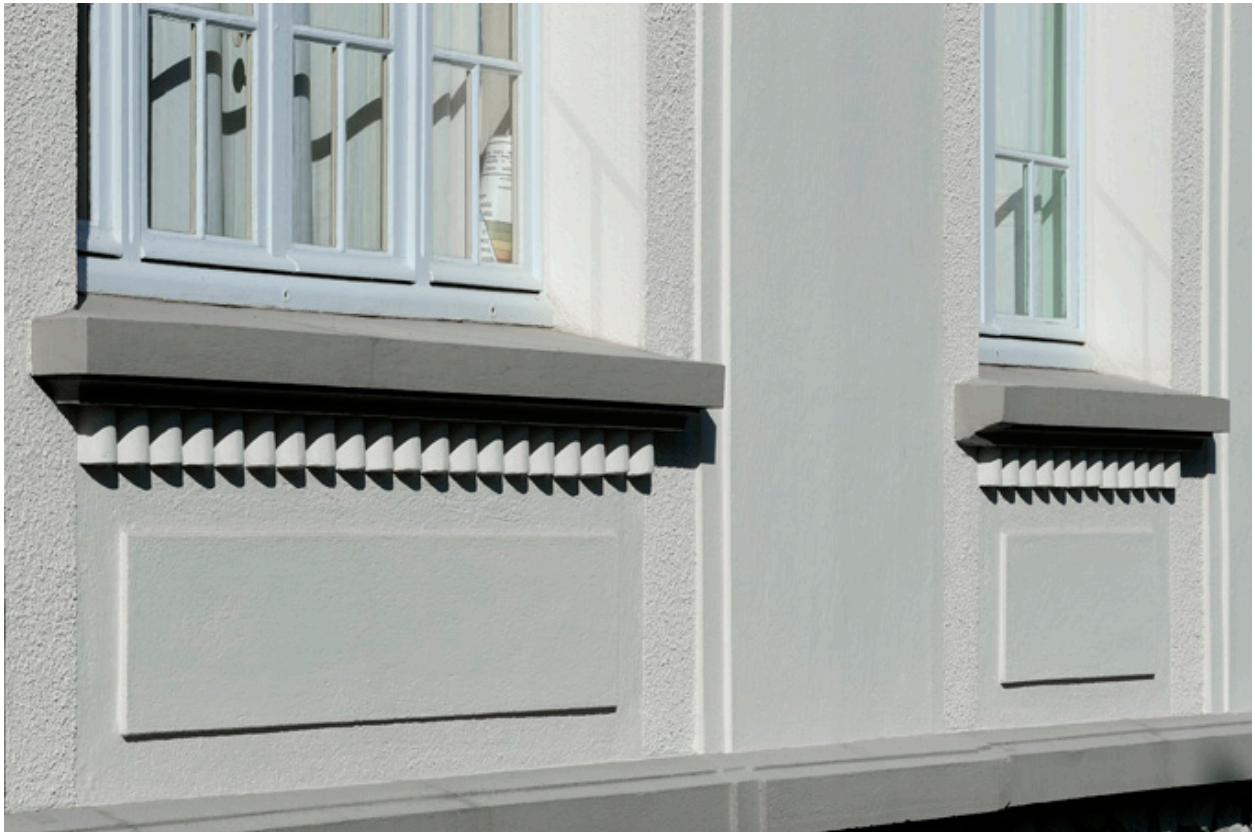
École : façade est, allèges et appuis de fenêtre à modillons
