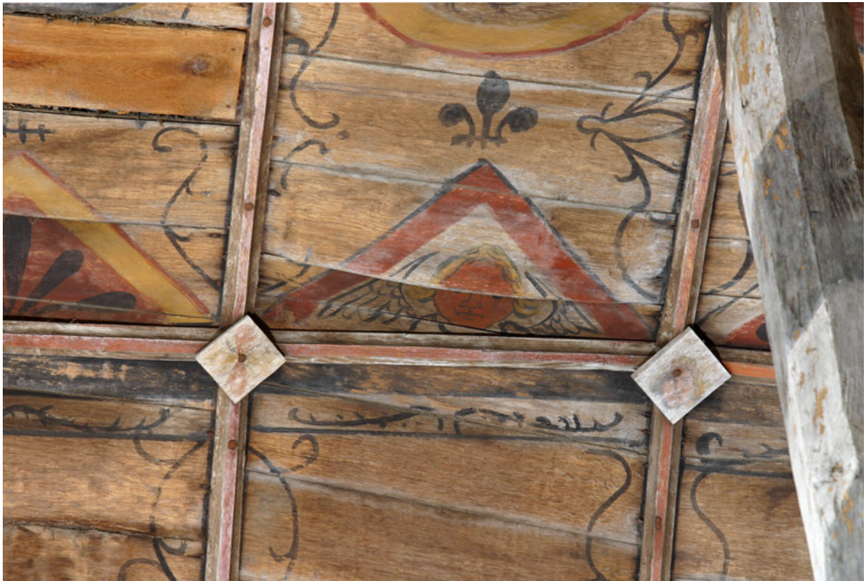
Nef, voûte, côté nord, deuxième travée, registre de faîte : ange.
