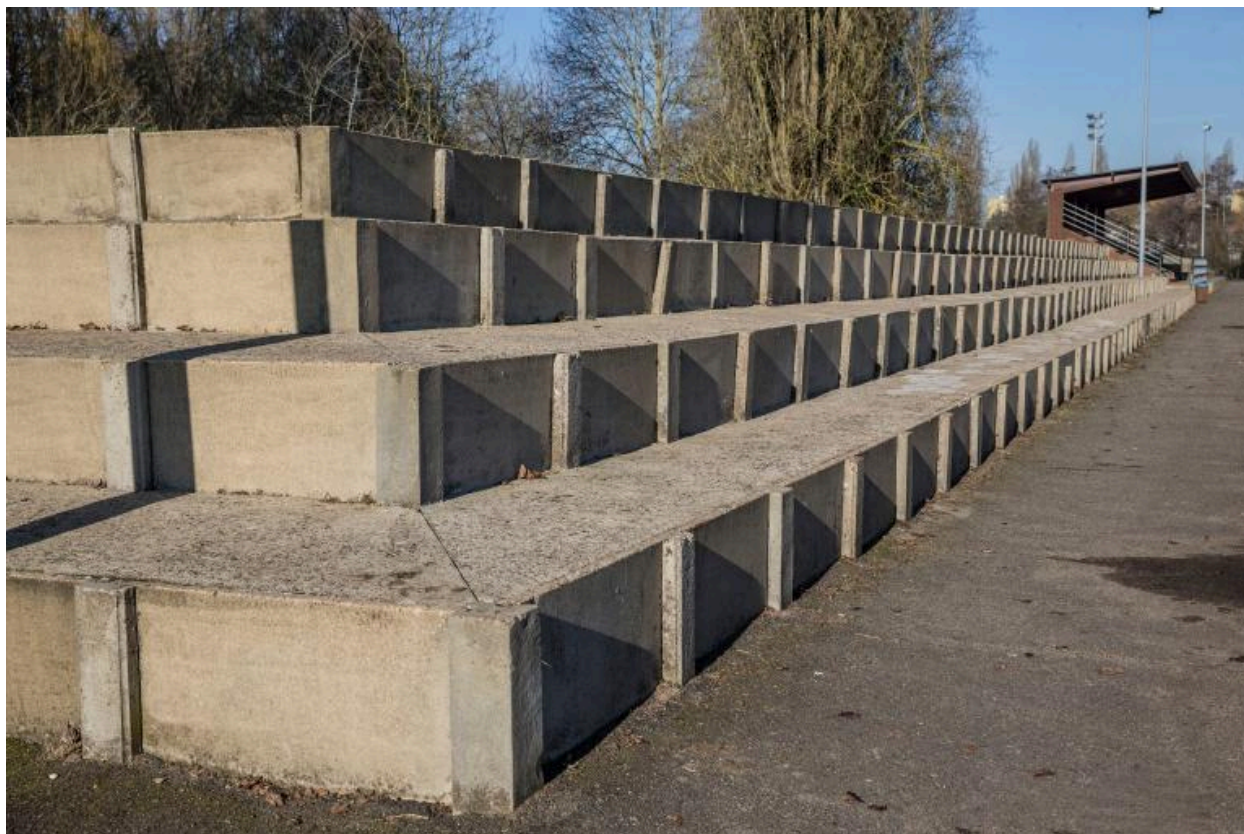
Détail des gradins.
