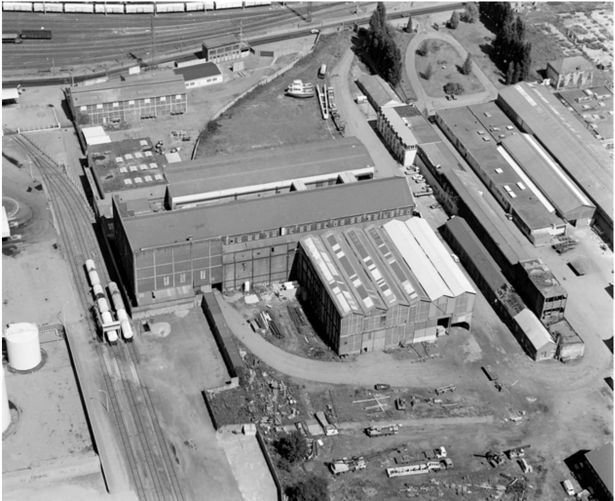
Bâtiments de l'ancienne centrale électrique de Chantenay, 1989.
