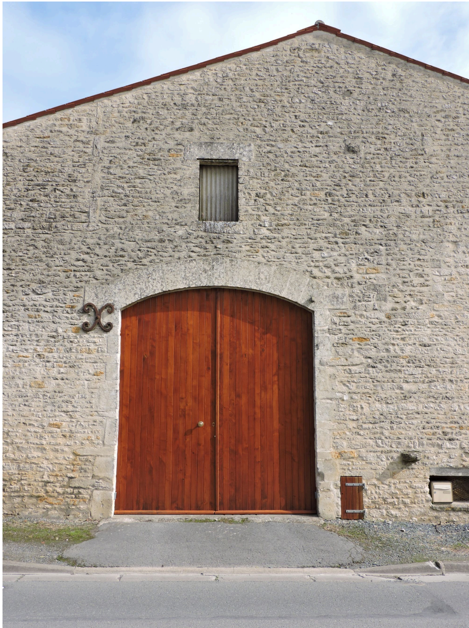
La porte des dépendances sur le mur pignon.
