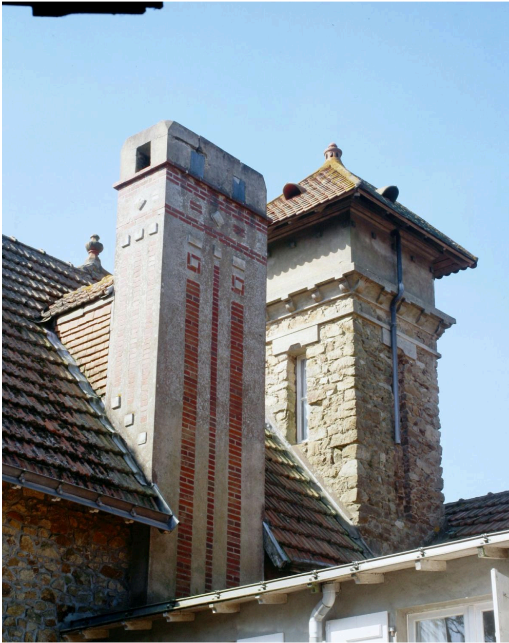
Belvédère et souche de cheminée.
