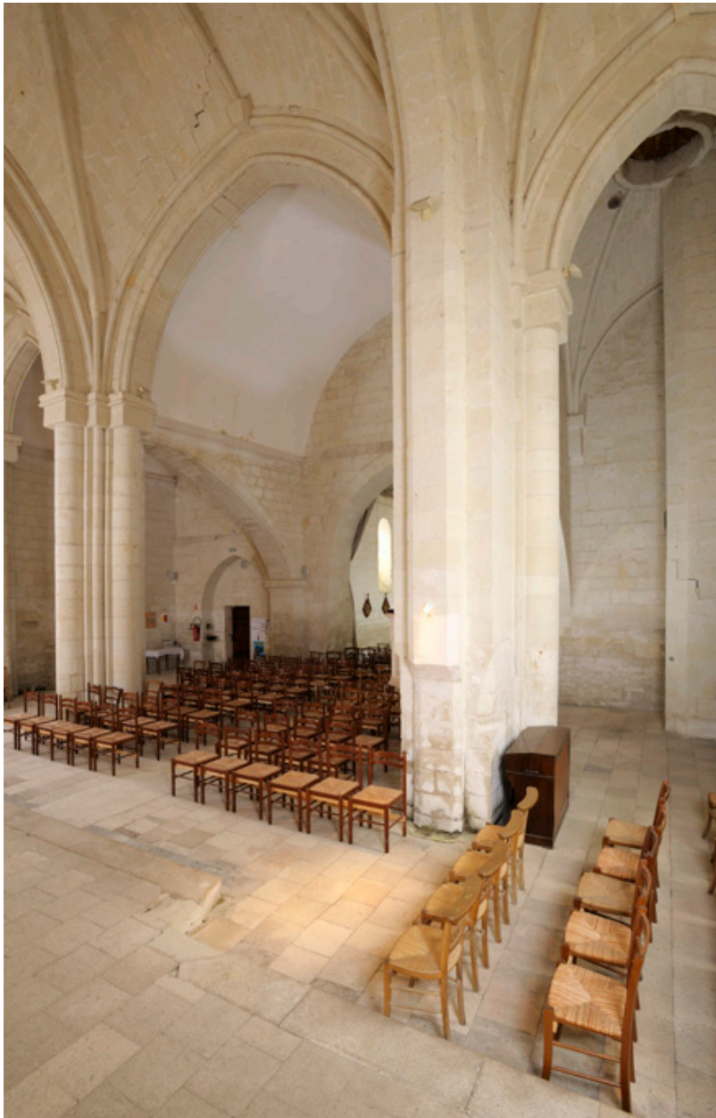
Les piles occidentales de la croisée du transept.
