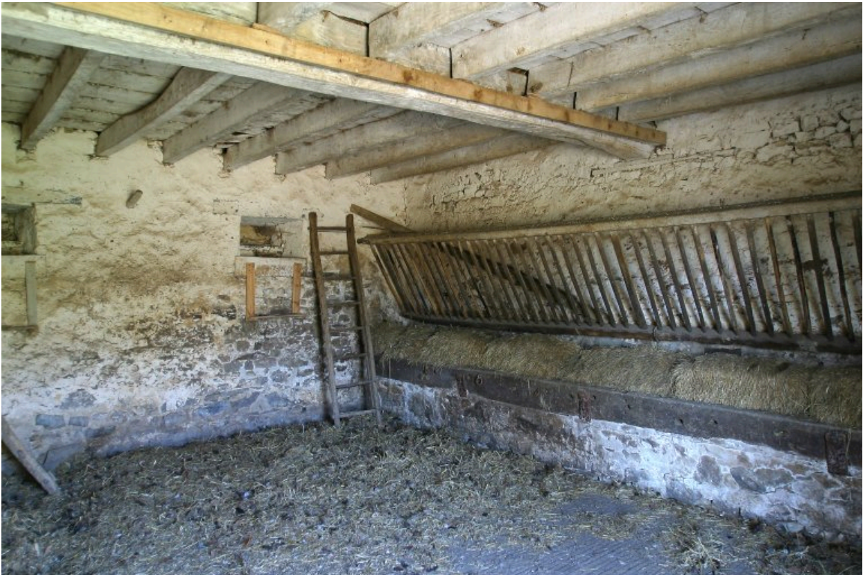
L'étable-grange, vue intérieure. L'étable à vaches (?).
