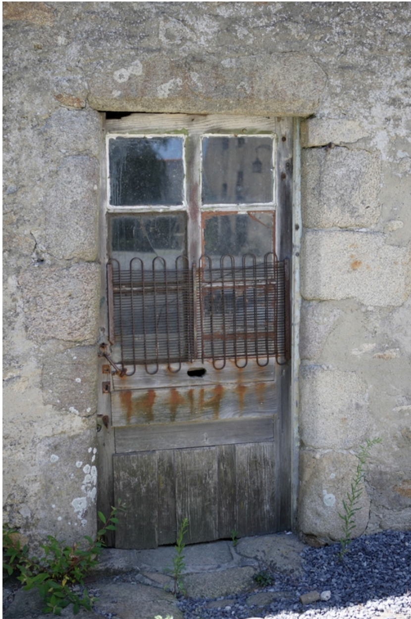
Bâtiment ouest. Façade est. Détail de la porte droite.
