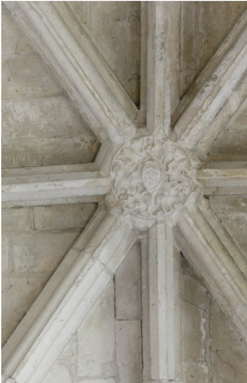
Bas-côté sud de la nef : clef de voûte de la première travée.
