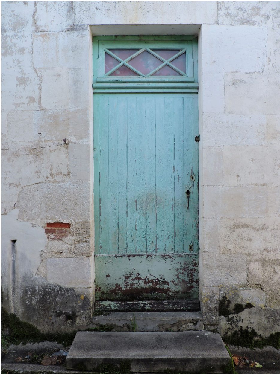
La porte à imposte sur le côté de la maison, dans la venelle du Sabotier.
