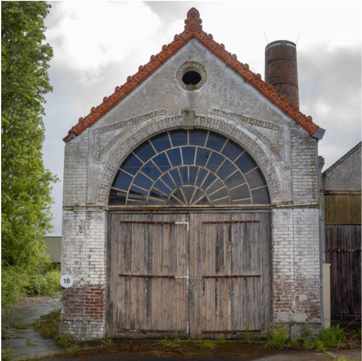
Façade principale de la chaufferie B de l'usine textile.
