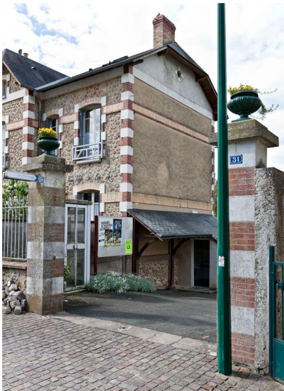
Villa des Acacias : vue de volume depuis le nord-est.
