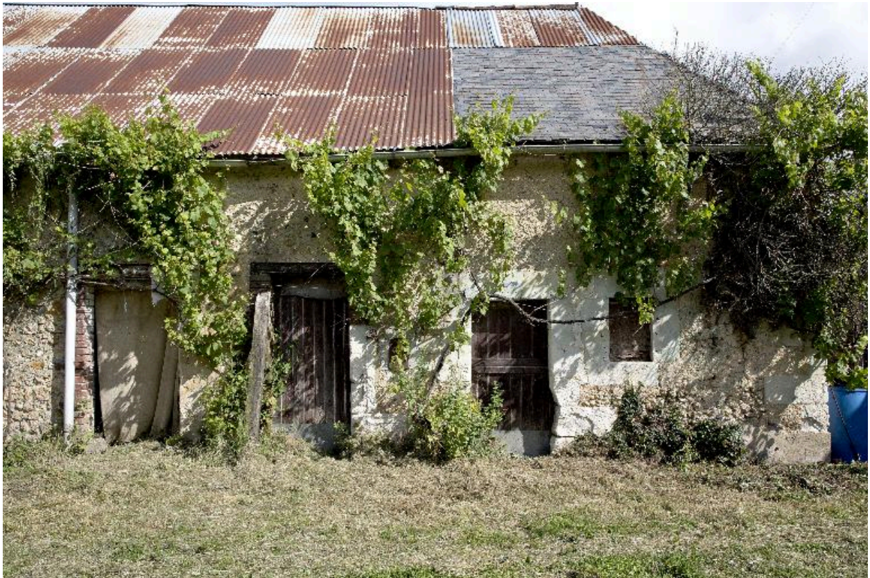
Etable et maison la plus ancienne (18e s.) : façade principale.
