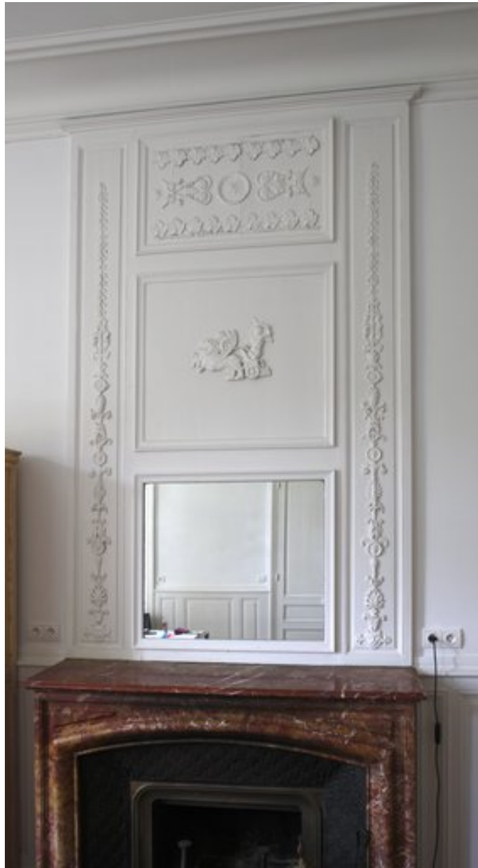
Trumeau de cheminée de l'une des pièces du rez-de-chaussée.
