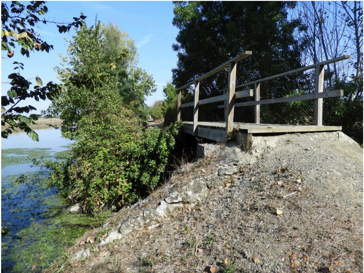
En amont du Gouffre, passerelle sur la Vieille Vendée, abandonnée en 1835.
