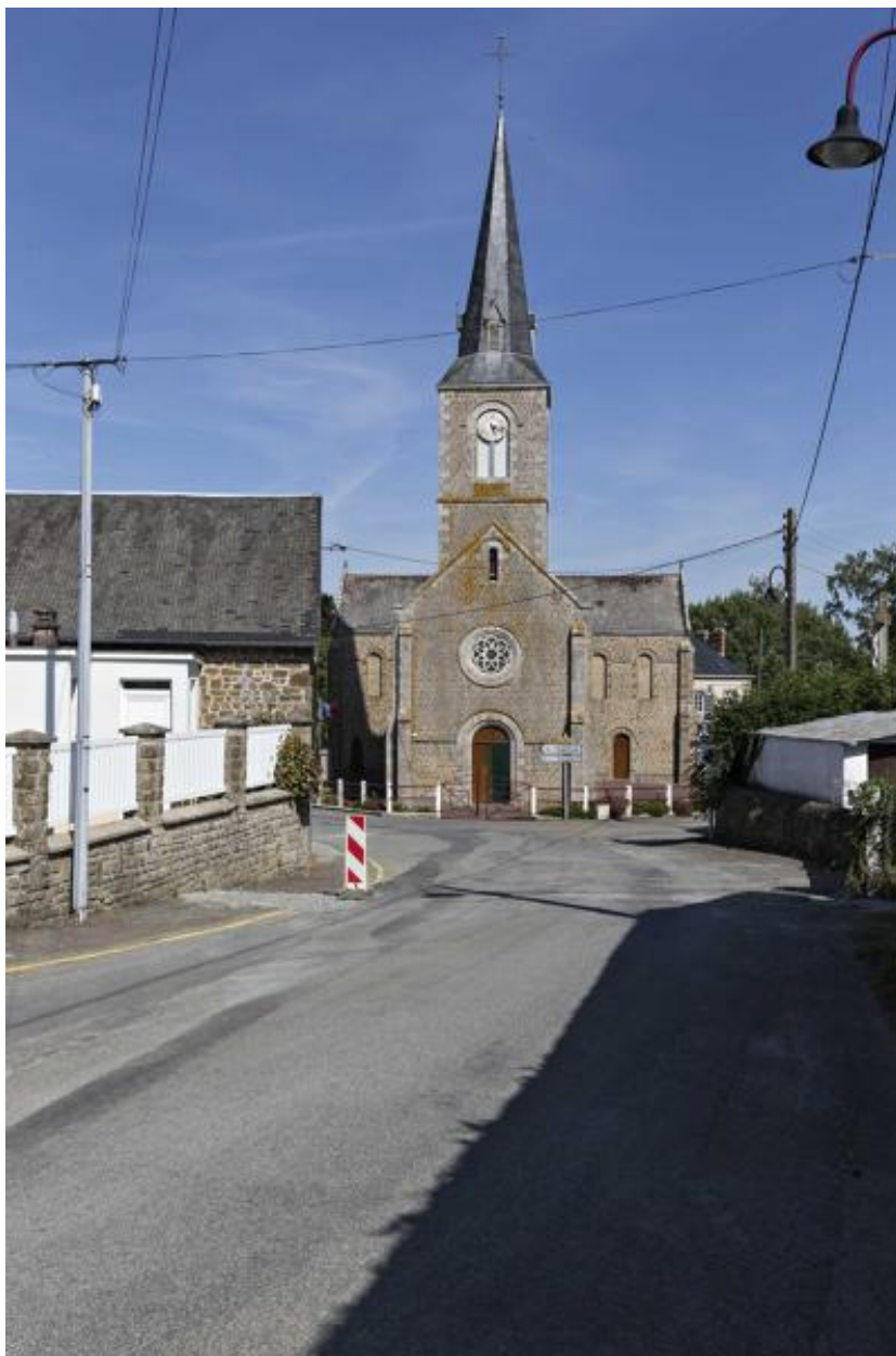
Façade occidentale de l'église de Sainte-Marie-du-Bois.
